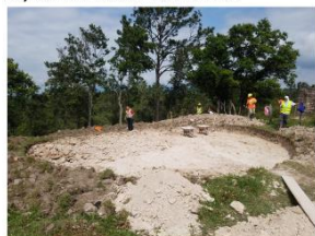
Plantel para Construcción de Tanque de 50,000 Gal. Sector Las Palmas
