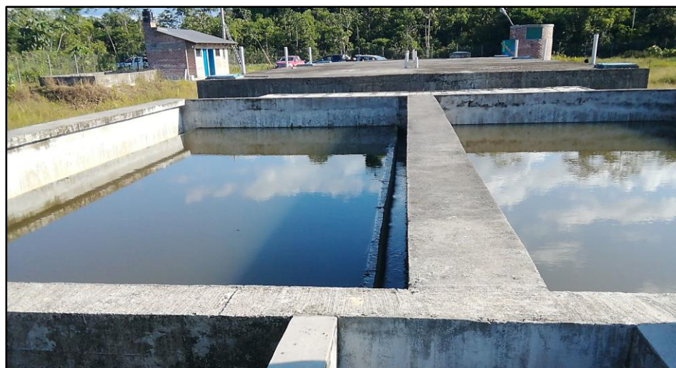
Vista general. PTAR Mariposas
